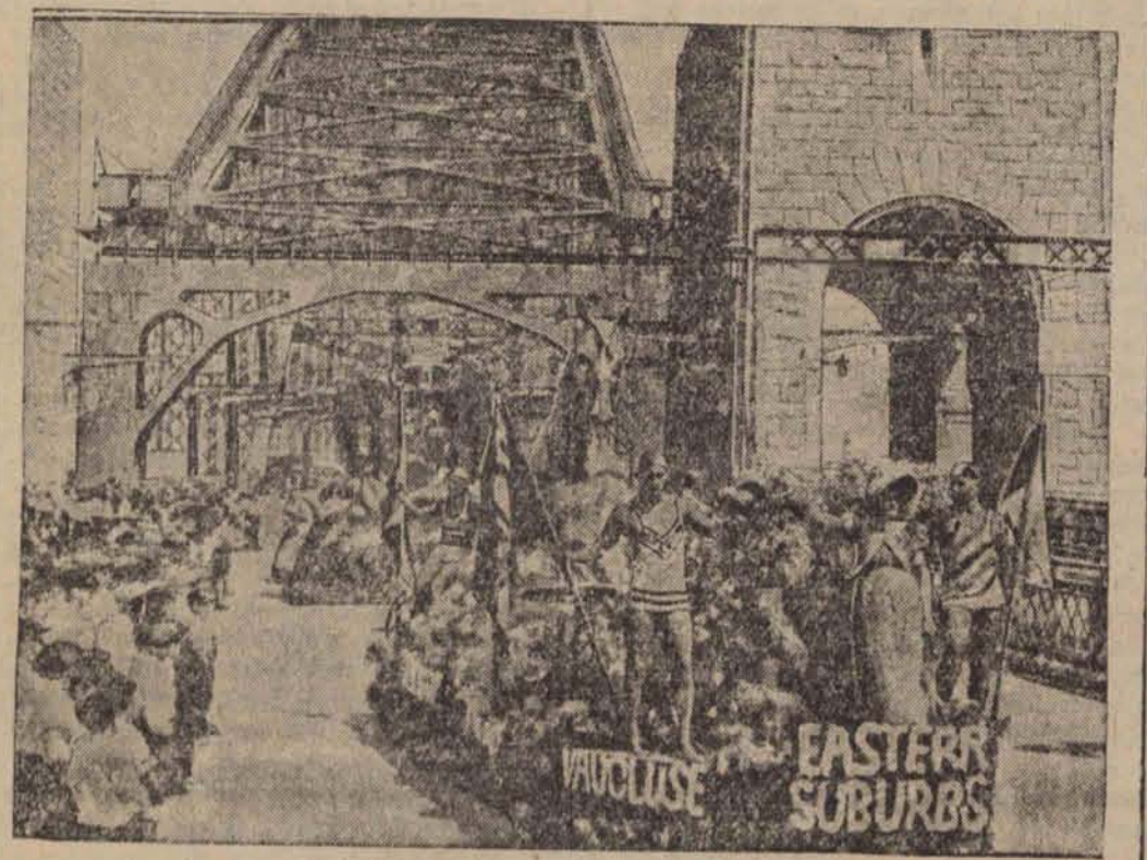
Przejazd symbolicznych grup przez nowo otwarty olbrzymi most w Sidney (Australia), którego budowa trwała 10 lat i kosztowała 10 milionów funtów (35 milionów złotych).
