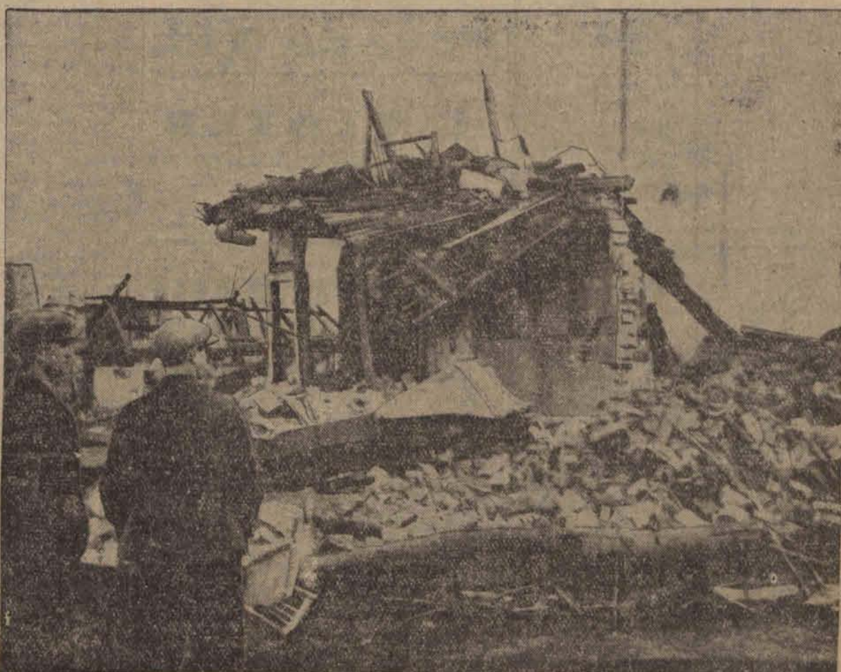
2) Gruzy jednego ze zniszczonych wybuchem domów mieszkalnych.
