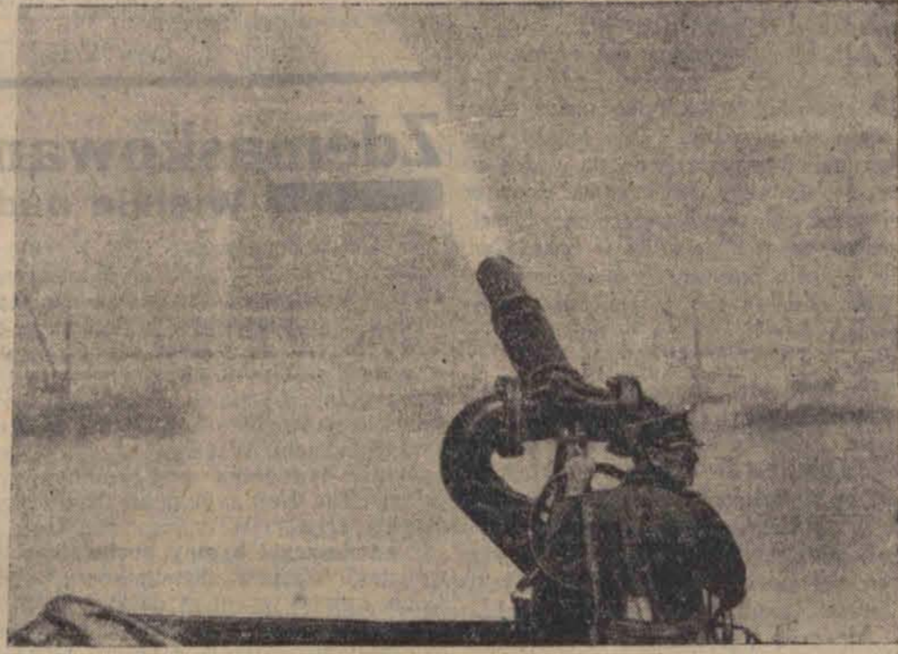
Nowojorska straż pożarna otrzymała nową łódź pożarną, która z 29 rur wy- rzuca w minucie 48 tonn wody. Na ilustracji jedna z 15 cm. „armat wodnych”.
