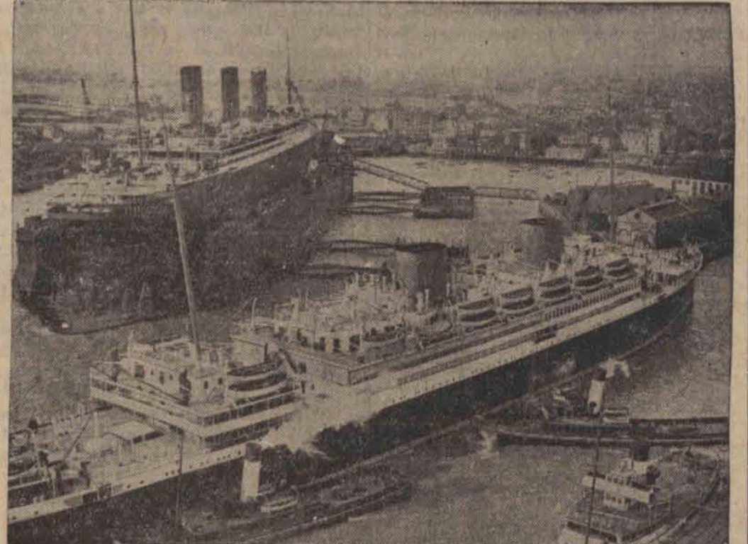
W potężnych dokach Southampton znajdują się obecnie w remoncie dwa potężne kolosy oceaniczne: „Alcantara” i „Berengaria” (na drugim planie).
