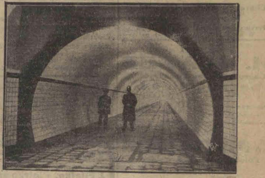
Gigantyczne twory techniki współczesnej — tunele pod rzeką Skaldą w Belgji. Jeden z nich długości 500 m. przeznaczony jest dla pieszych, drugi długości 2 km. dla ruchu kołowego. Otwarcie tunelu nastąpi 10 września b. r.
