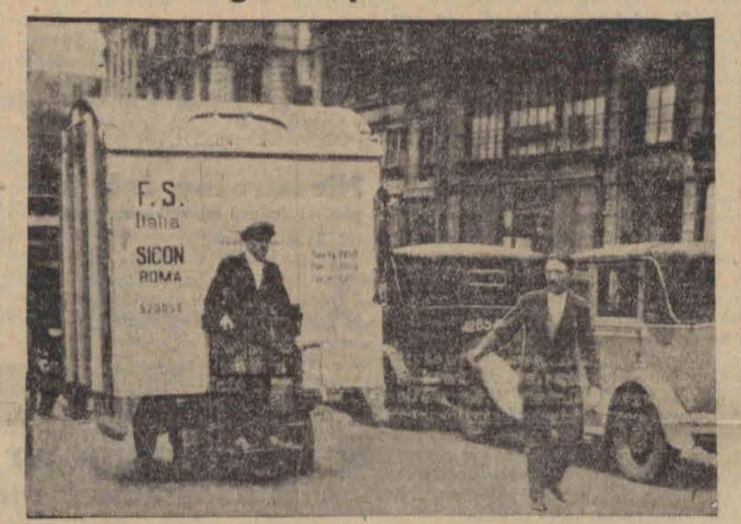
Włosie wprowadzili nowy system transportowy: Małe wagoniki zaplombowane, zabierane są wprost z wagonów kolejowych na samochody ciężarowe i dostarczane wprost do adresata. Na ilustracji: Wagonik nadesłany z Włoch na ulicy Paryża w drodze do adresata.
