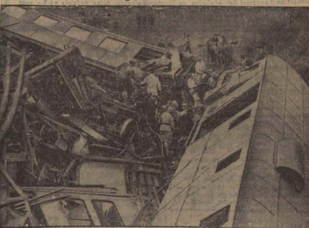
Usuwanie rozbitych wagonów w pobliżu Bonneville gdzie pociąg pociąg przesylny runął z mostu do rzeki. Z pod szczątków wydobyto dotychczas przeszło 40 trupów i 100 rannych.
