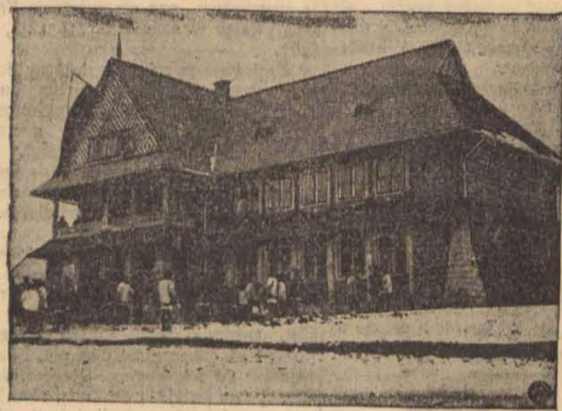
Widok ogólny Wysokogórskiej Szkoły Rolniczej w Żabiem dla absolwentów Szkół Powszechnych, która została w tych dniach otwarta. Jest to trzecia tego rodzaju szkoła rolnicza w Polsce. Szkoła składa się z obszernego 2-piętrowego gmachu, wzorowych zabudowań gospodarczych, budynków mieszkalnych i 22-u hektarowej parceli doświadczalnej, ofiarowanej przez gminę Żabie.
