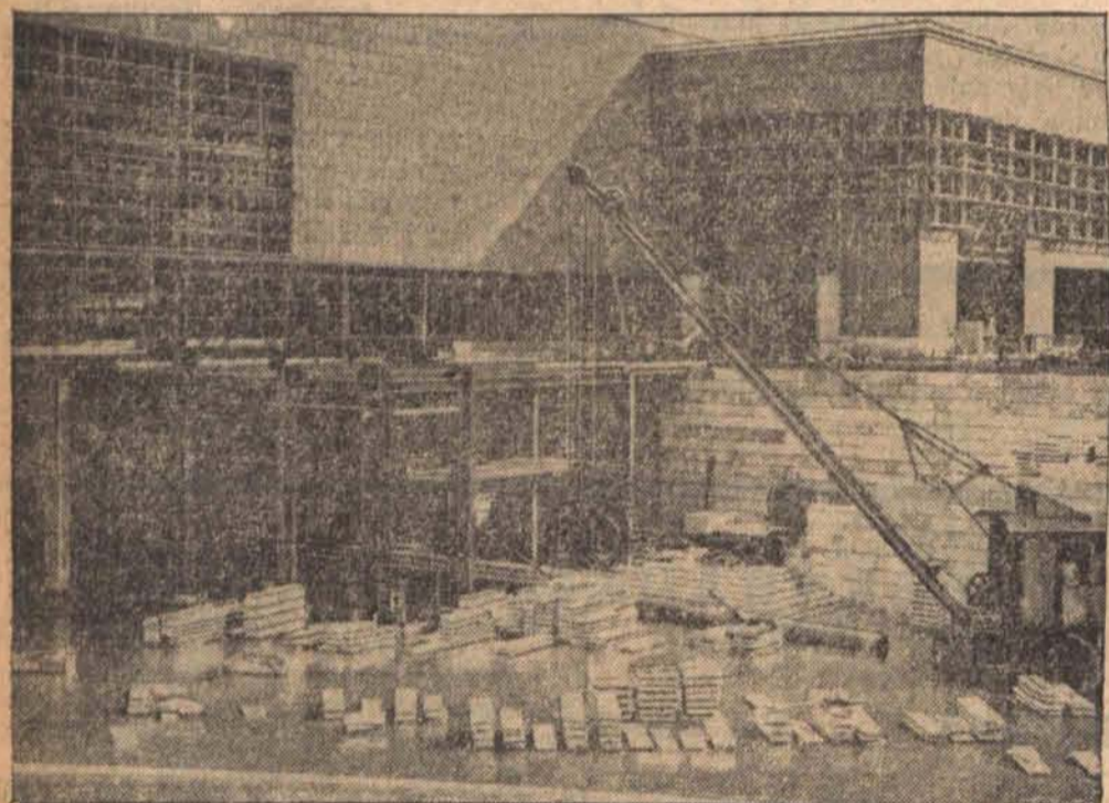
Wylew Sekwany w Paryżu zmusił kierownictwo robót na terenach wystawy światowej do wstrzymania budowy pawilonów.
