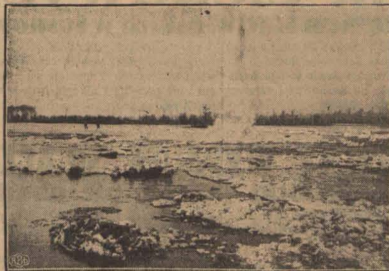
Onegdaj wojsko rozbiło zator lodowy, który utworzył się w pobliżu wsi Konopnicy. Na zdjęciu eksplozja naboju saperskiego.
