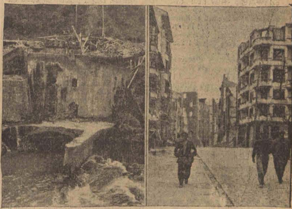
Przed opuszczeniem Eibar komunisti podpalili miasto niszcząc systematycznie całe dzielnice. Po lewej stronie wysadzona w powietrze elektrownia wodna na rzece Deva. Na prawo: Mury spalonych domów.
