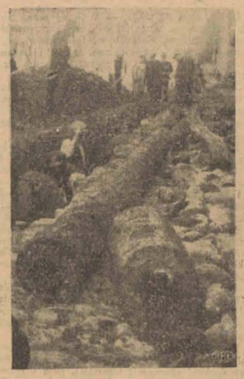
Olbryzia drewniana rura wodociągowa sprzed 400 lat wykopana w Sieradzu podczas robót na ul. Dominikańskiej. Wodociąg ten był założony za czasów króla Kazimierza Jagiellończyka.
