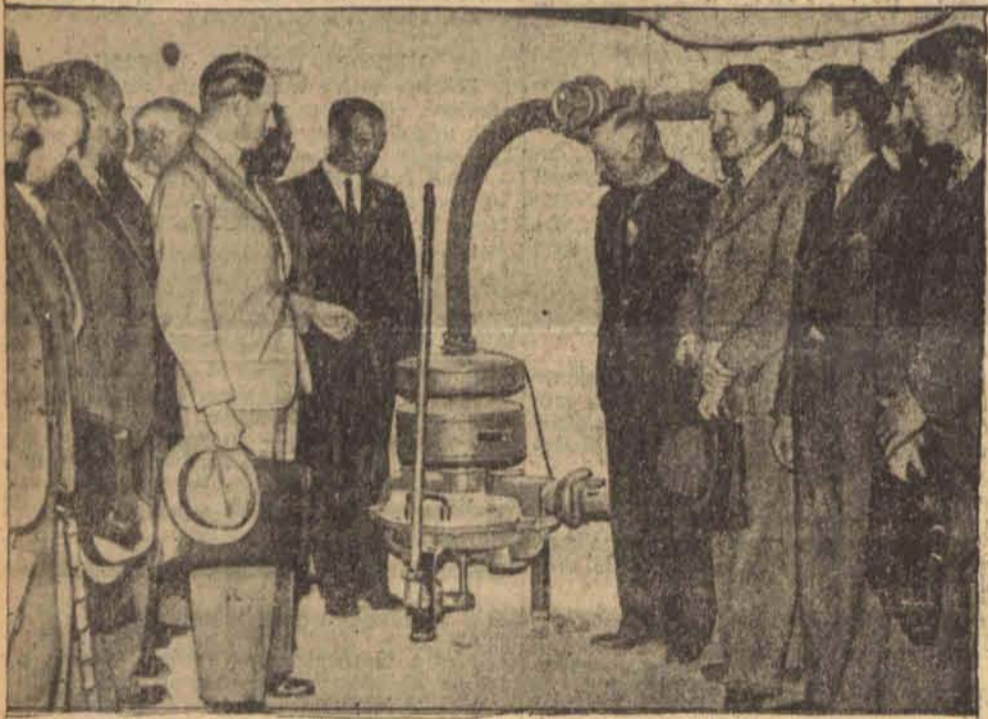
W Sztokholmie wybudowano w nowym gmachu rządowym pierwszy schron przeciwbombowy, w którym mogą się pomieścić wszyscy urzędnicy, pracujący w tym urzędzie. Na zdjęciu widzimy aparat do oczyszczania zagazowanego powietrza.
