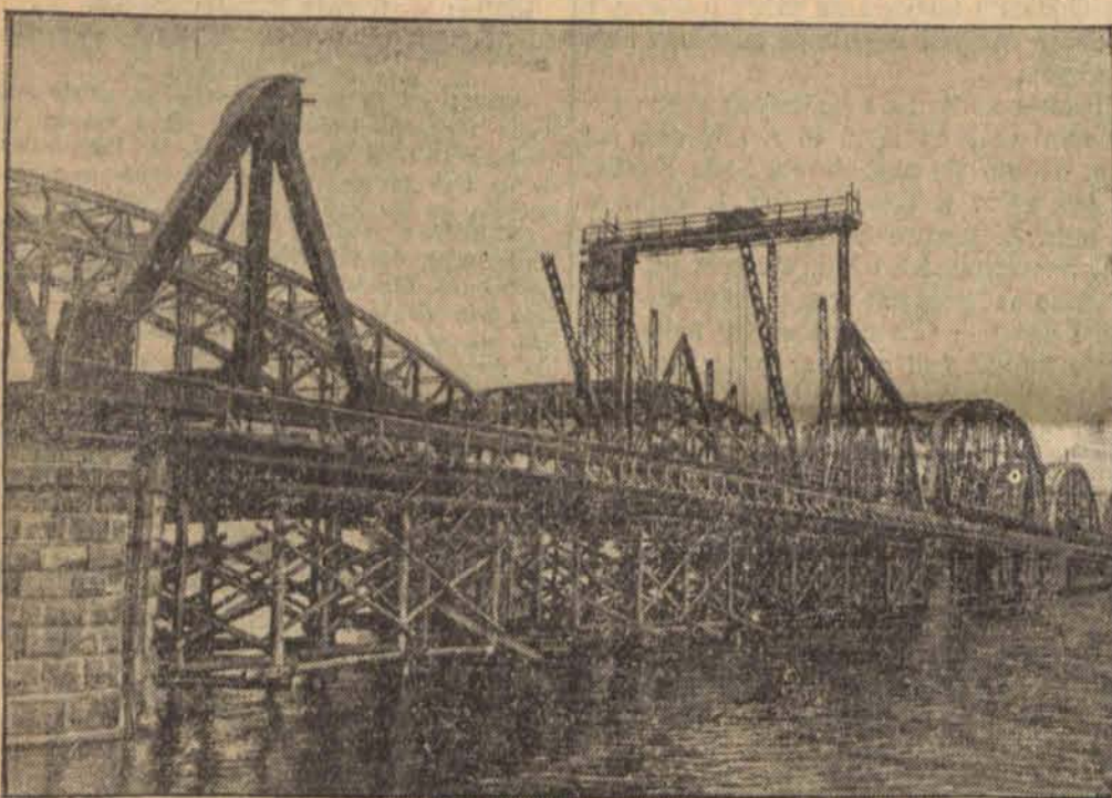
Budowa nowego mostu kolejowego przez Dźwinę w Rydze dobiega końca.
