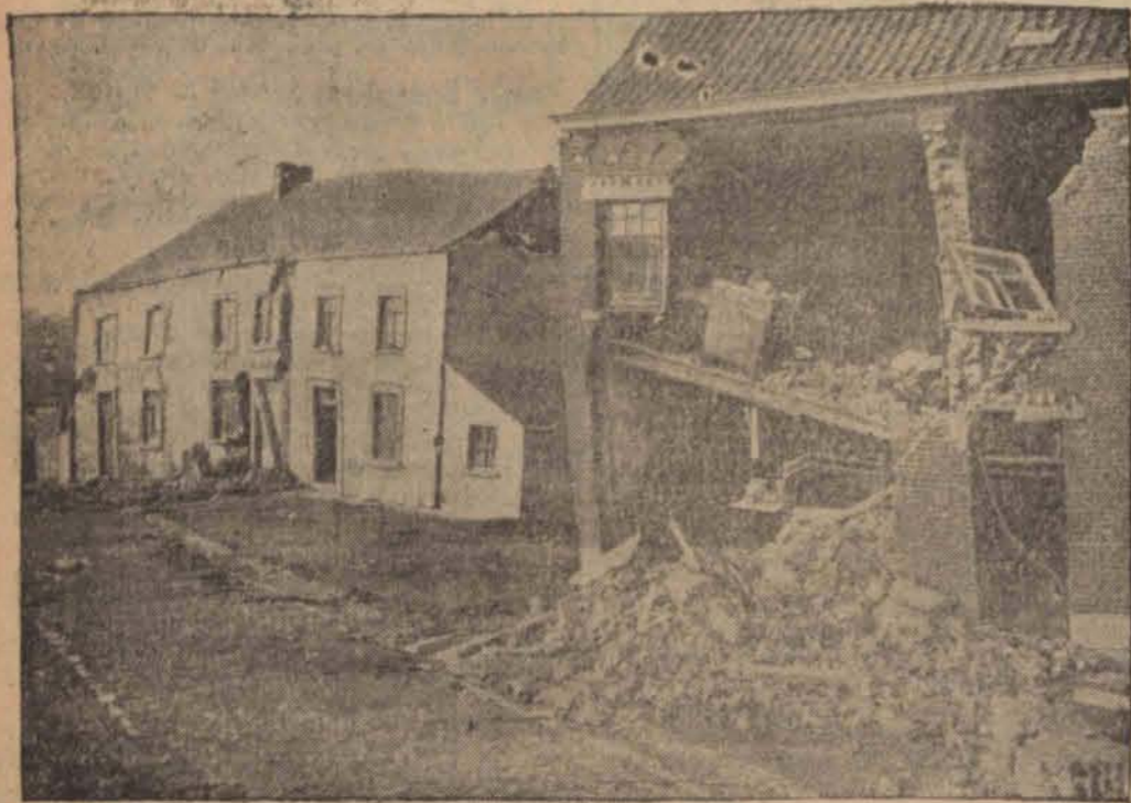
W Souvret (belgijskie zagłębie węglowe Charleroi) zawaliło się około 20 domów, wskutek podziemnych wstrząsów tektonicznych.
