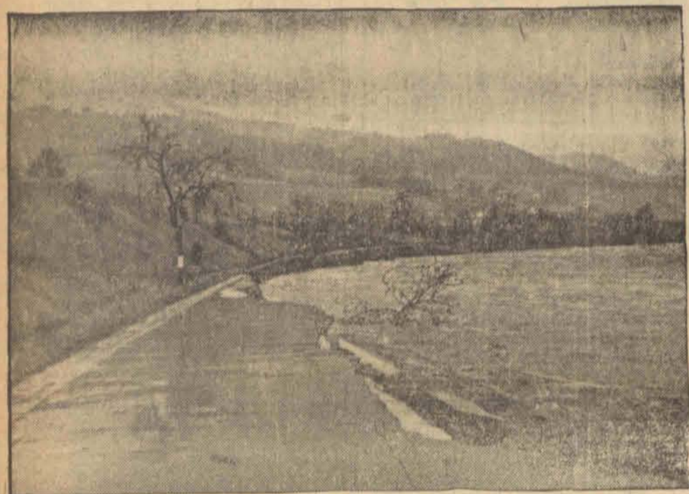
Betonowa szosa między Leoben i Graz została zupełnie zniszczona przez powódź.
