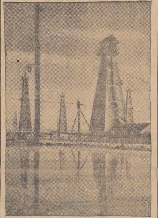
Koło Zistersdorf w pobliżu Wiednia, znanego dotychczas z uprawy wina, dowieczono się naftę, którą w braku cystern zamagazynowano w otwartych zbiornikach ziemnych.
