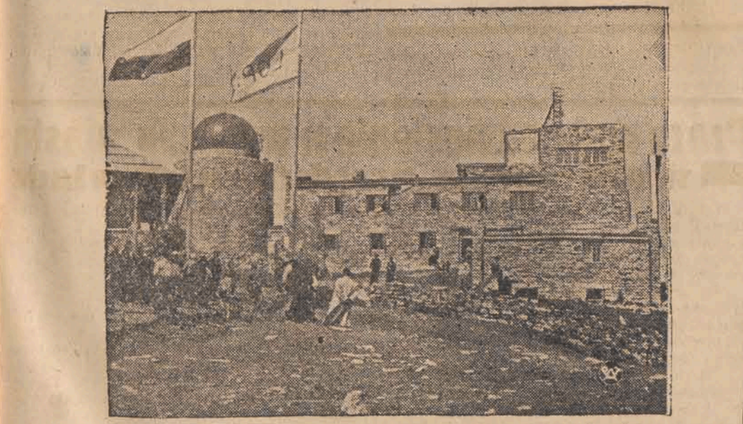
Staraniem LOPP przy poparciu i współpracy władz urzędowych, wybudowany został na szczycie Pop Iwana (ponad 2000 metrów nad poziomem morza) wspaniały gmach obserwatorium meteorologiczno-astronomicznego. Widok ogólny obserwatorium.
