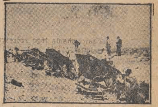
Przy budowie nowej drogi.
