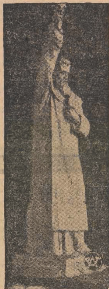
W Szczytnikach koło Iwanowic, obok Kalfsza, rozpoczęto budowę pomnika bohatera Jasnej Góry, ks. Kordeckiego. Podczas swej inspekcji na terenie powiatu kaliskiego, p. premier gen. Składkowski zbadał dokonane roboty przy budowie pomnika i wydał doraźne dyspozycje. Na zdjęciu — makietę pomnika ks. Kordeckiego.
