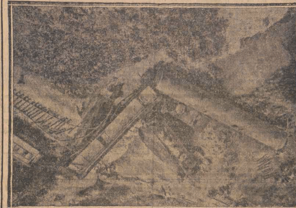
Pociąg pośpieszny na linii Canadian Pacific runął wskutek podmycia mostu do rzeki. Na zdjęciu wykonanym z lotu widzimy stalowe wagony na dnie wąwozu.
