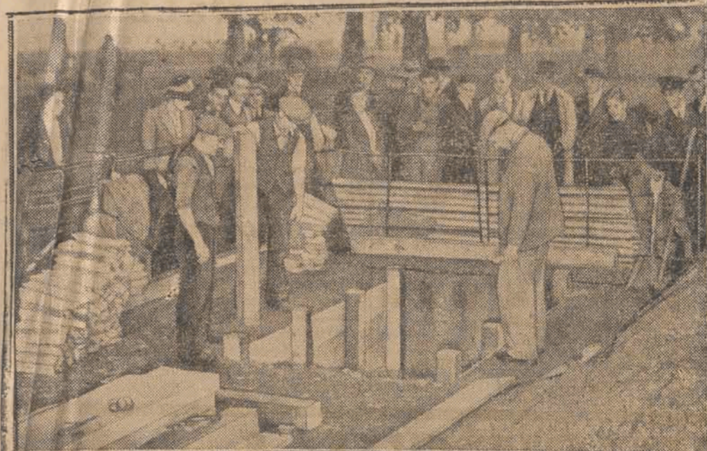
W rozległym Hyde-Parku londyńskim Liga Obrony Przeciwlotniczej zbudowała kilkanaście schronów. Na zdjęciu: budowa schronu.
