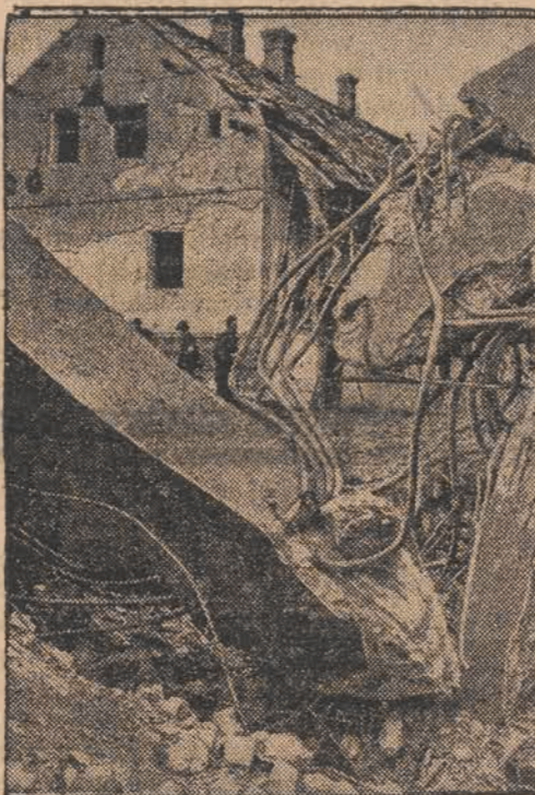
1) Tuż przed ustąpieniem z IV strefy sudeckiej Czesi wysadzili olbrzymim ładunkiem most żelbetonowy w Breitenfurt. 2) Siła wybuchu była tak wielka, że w leżącej od miejsca eksplozji o 200 metrów szkole wyleciały wszystkie okna i zostały uszkodzone sufity.
