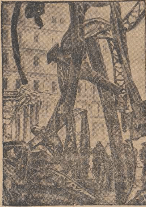
O nateżeniu pożaru świadczą poskręcane w ogniu belki i konstrukcje żelazne.
