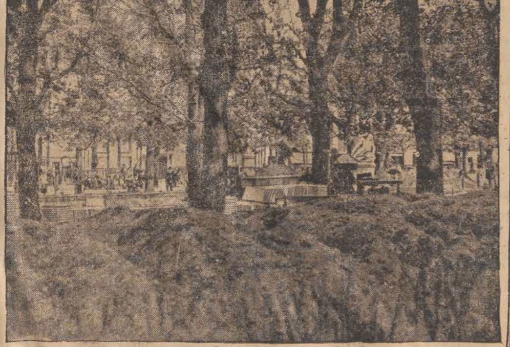
W ogrodzie Luksemburskim przystąpiono do budowy schronów przeciwgazowych.
