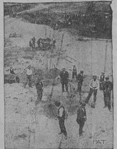
Na zdjęciu powyższem widzimy roboty ziemne prowadzone na peryferiach stolicy.
