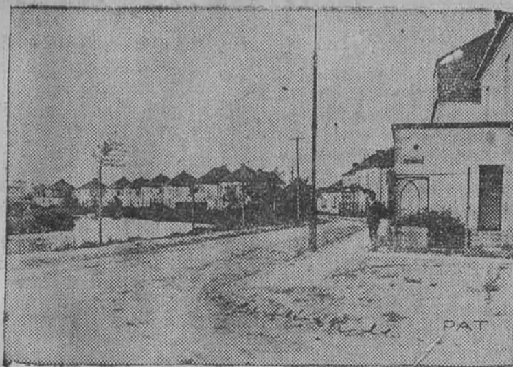
W dzielnicy Czerniaków-ogród wybudowano ostatnio szereg pięknych domów mieszkalnych, nową tę kolonię nazwano „Sadybą oficerską”.
