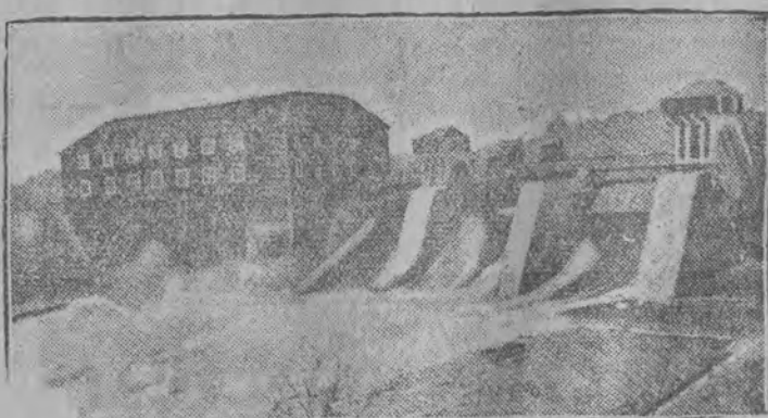
Widok elektrowni w Forshuvudforsen.
