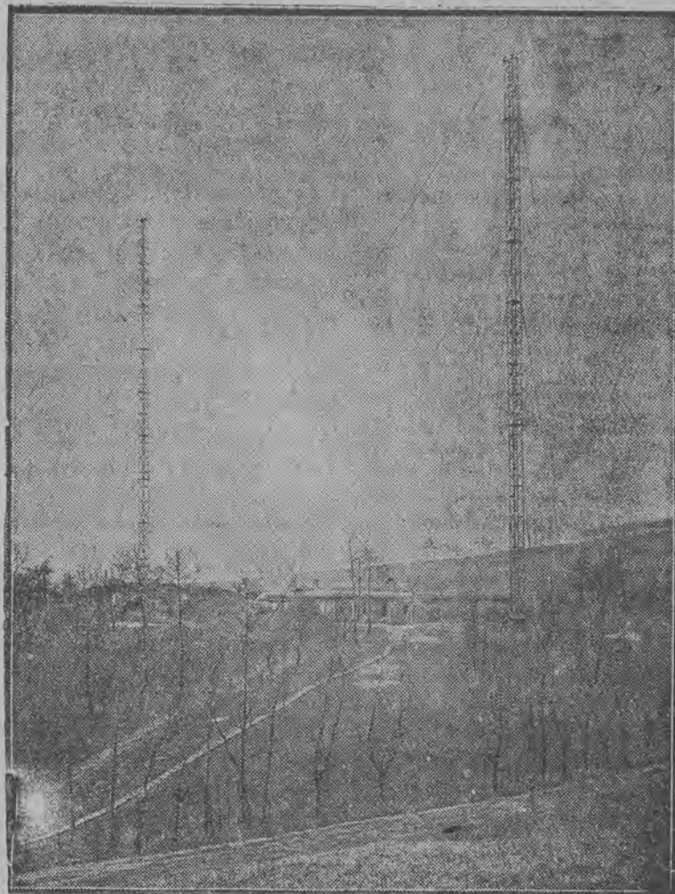
Ogólny widok nowej radjostacji krakowskiej.
