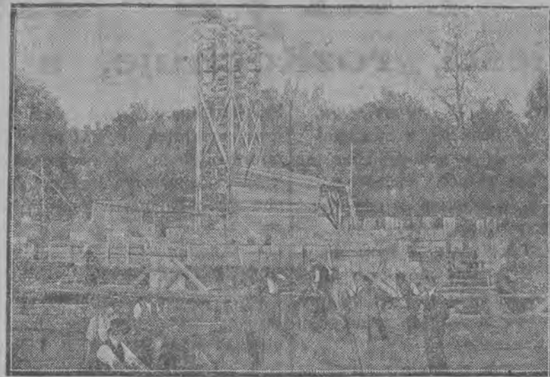
Budowa czyni bardzo szybkie postępy
