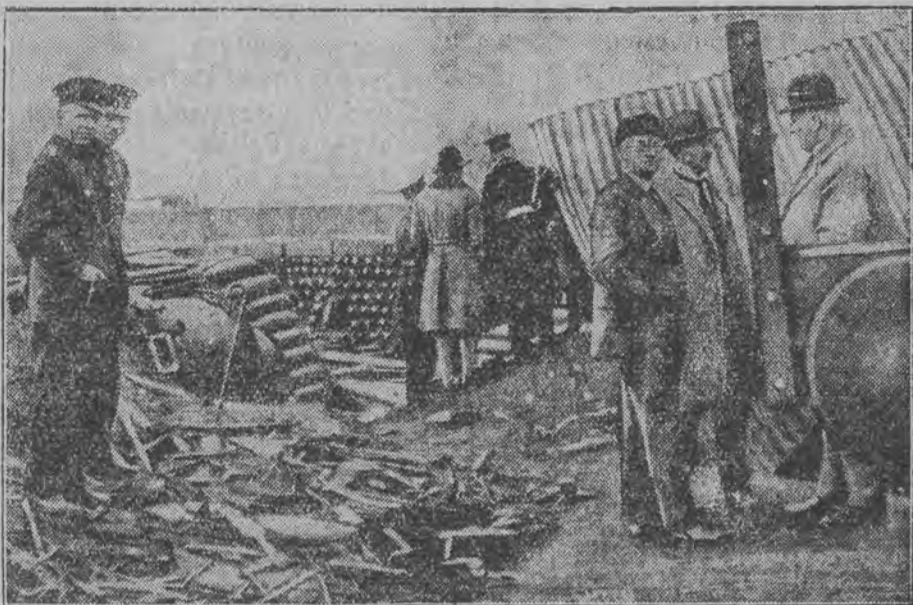
Zniszczenia dokonane przez wybuch fosgenu.
