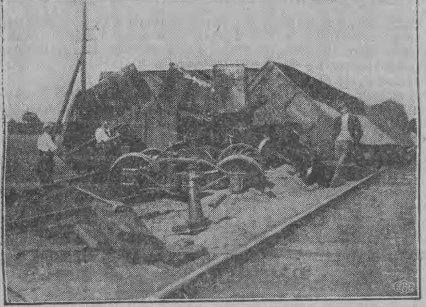
Straszny obraz zniszczenia na torze pod Gałkówką.
