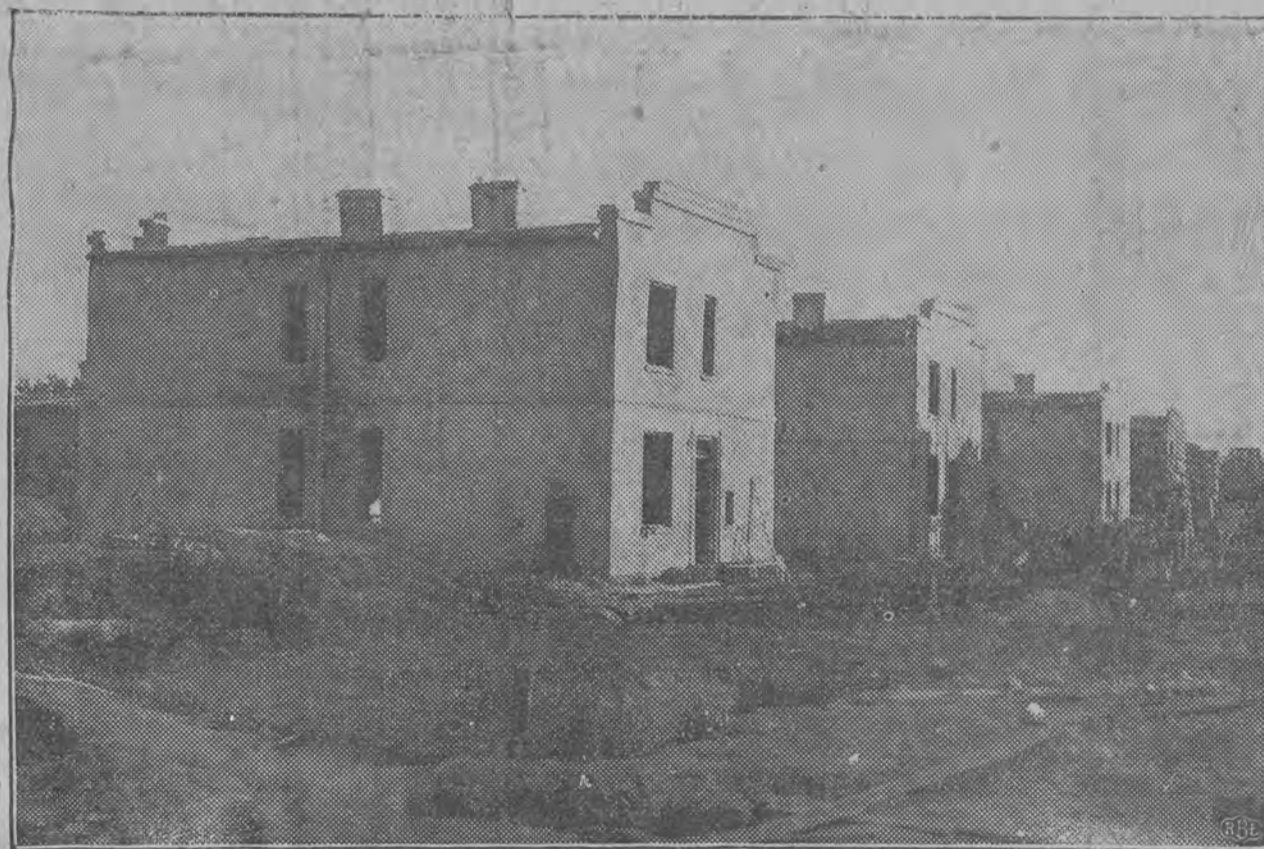
Kompleks wykończonych domków robotniczych.
