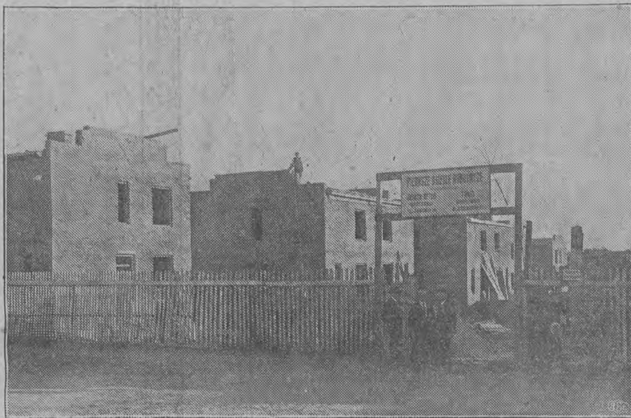
Widok na gotowe budynki od głównego wejścia przy ul. Wileńskiej.
