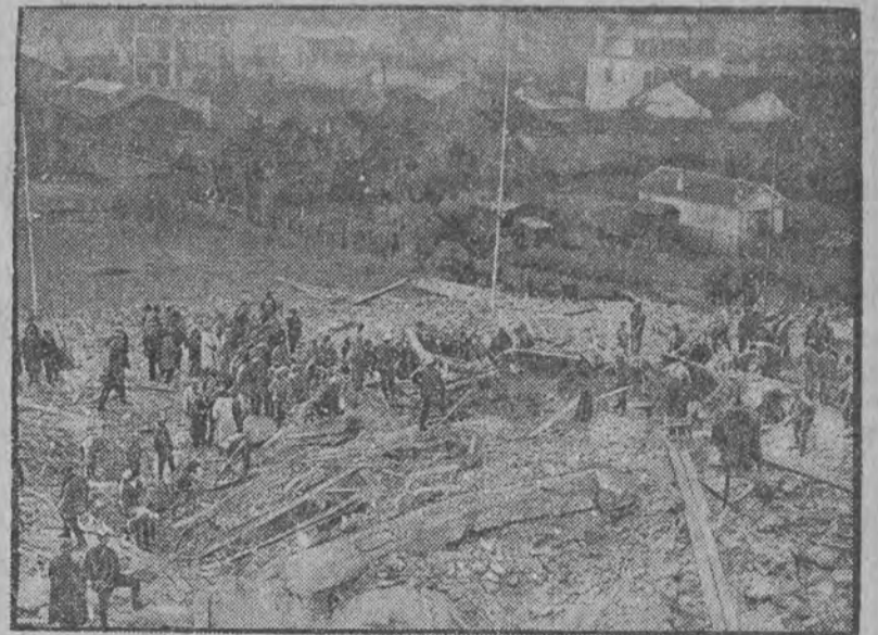
W tych dniach, jak to donosiliśmy w depezach, runął w Vincennes nowostawiany dom 7-mio piętrowy, zasypując 25 robotników, pracu- jących podówczas przy budowie. Na ilustracji naszej widzimy zwa- liska tej nowoczesnej rudery w czasie poszukiwania ofiar
