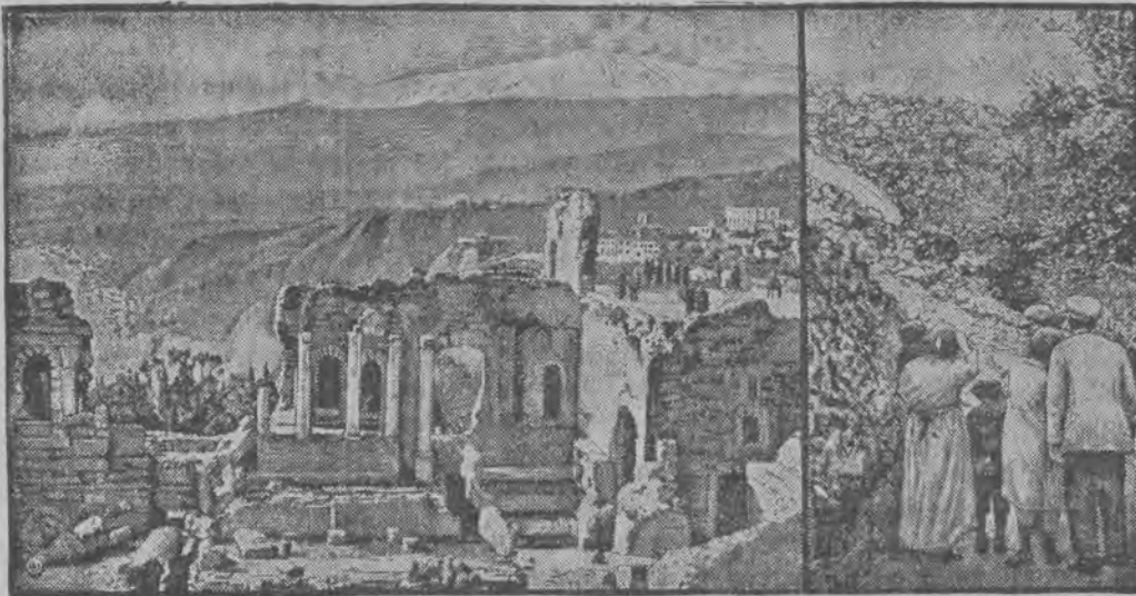
Zniszczenie spowodowane przez siły podziemne.
