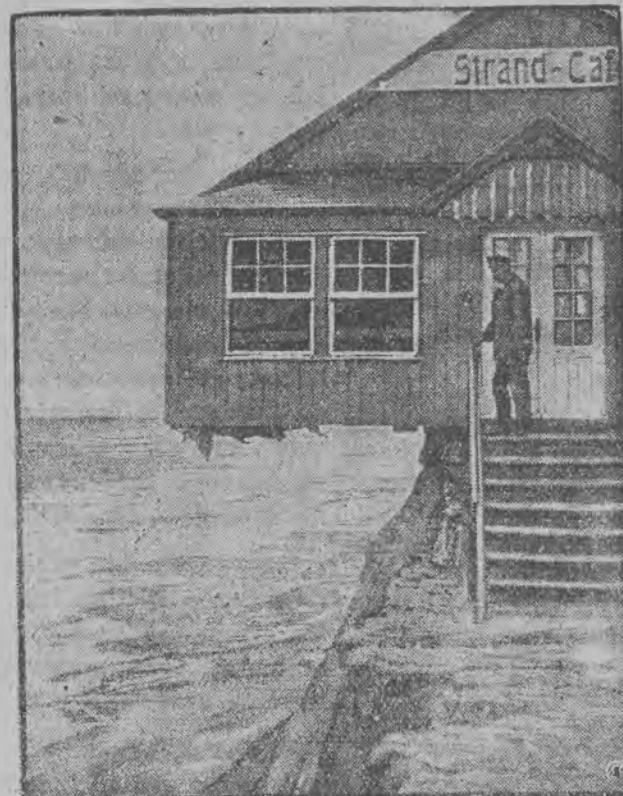
Wezbrane fale rzeki zalewają nadbrzeżną kawiarenkę.
