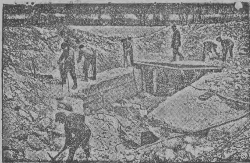
Rozwalanie betonowych schronów i zasypywanie rowów dobiegowych w Kistrzyniu.
