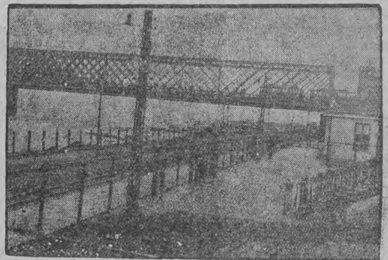
Najniebezpieczniejsze momenty przyboru Wisły już minęły. Stacja Most kolejki podjazdowej w Warszawie mimo groźnych wieści nie uległa zniszczeniu przez wezbrane wody Wisły.
