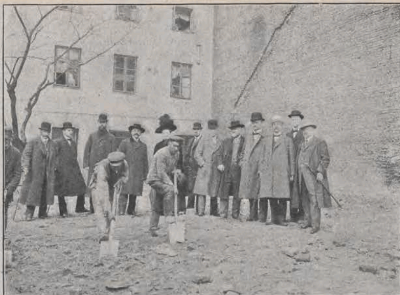
W obecności członków Stow. Prac. Handl. i Przemysł. rozpoczęto roboty ziemne pod budowę własnej siedziby.
