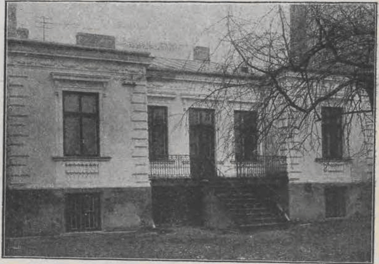
Schronisko Dzieci Marji. Pawilon frontowy przy ul. Rakowieckiej № 7. (Fot. W. Orłowski).
