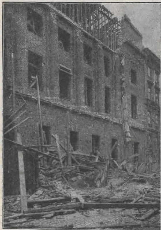
Zawalenie się biblioteki publicznej im Kierbedziów przy ul. Koszykowej.
