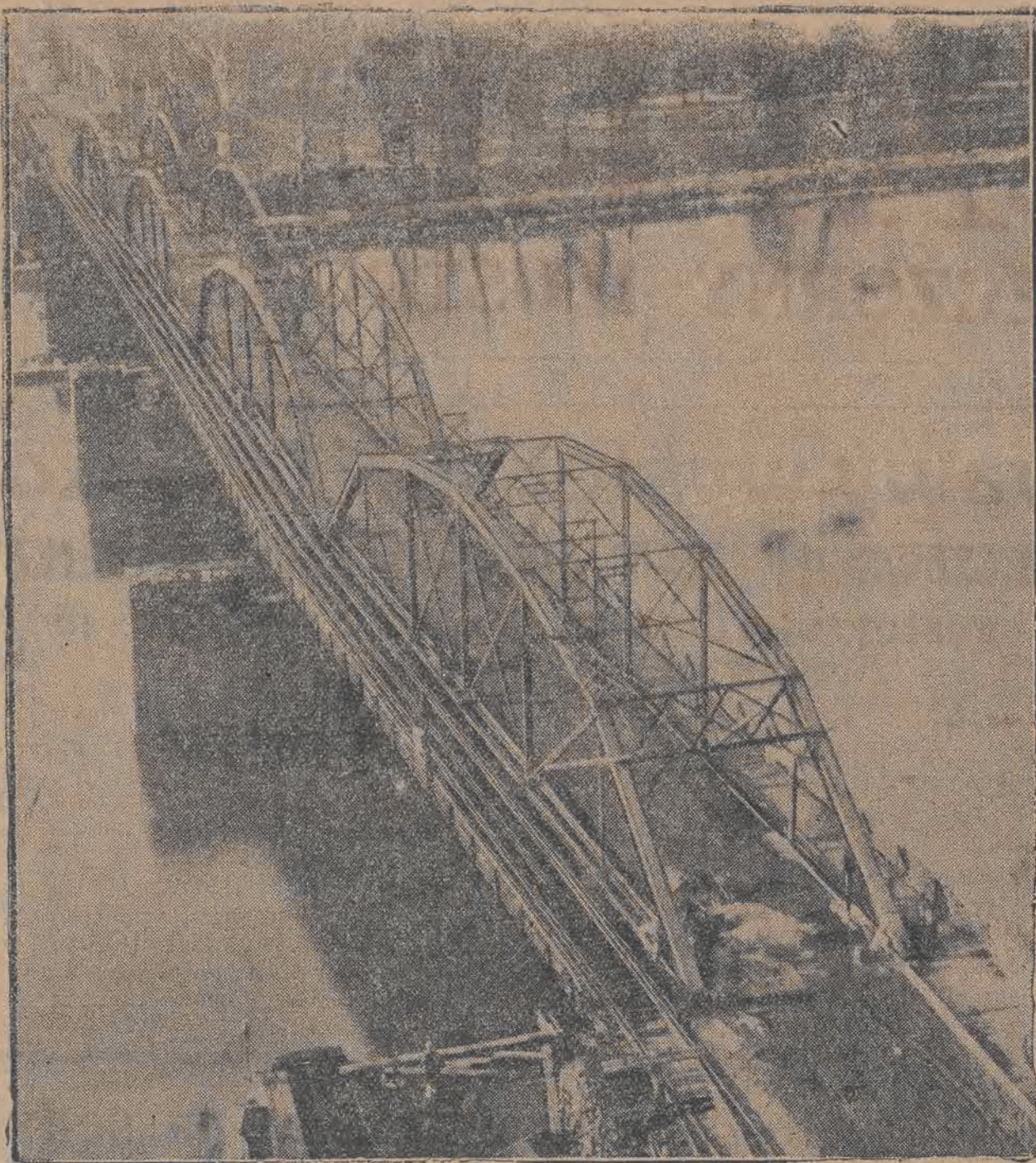
W mieście Kingstone w Stanach Zjednoczonych zbudowano most przesuwający się na własnych filarach. Wynalazek ten został wprowadzony celem umożliwienia skrzyżowania pociągów tuż przed mostem i uniknięcia nieszczęśliwych wypadków.
