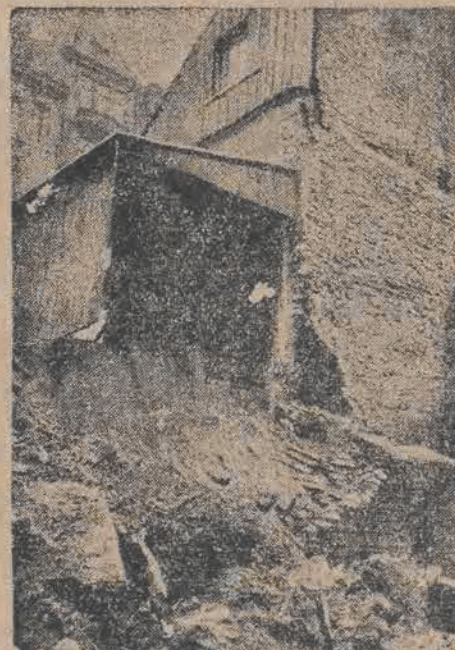
W ubiegłym tygodniu zawalił się częściowo dom przy ul. Kopernika w Warszawie, wskutek czego władze bezpieczeństwa nakazały wszystkim mieszkańcom opuścić zagrożony dom.
