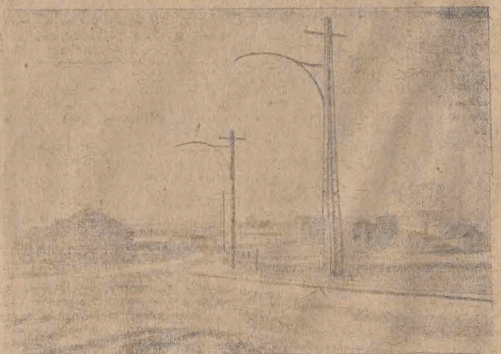
Prawdopodobnie w styczniu b. r. zostanie otwarta linia kolei elektrycznej na przestrzeni Będzin — Będzin — Dąbrowa Górnicza. Budowa trwała około 1 roku. Zdjęcie nasze przedstawia zw. zawieszenie tramwajowe na wygiętych wysięgach w ul. Dojazd w Będzinie.
