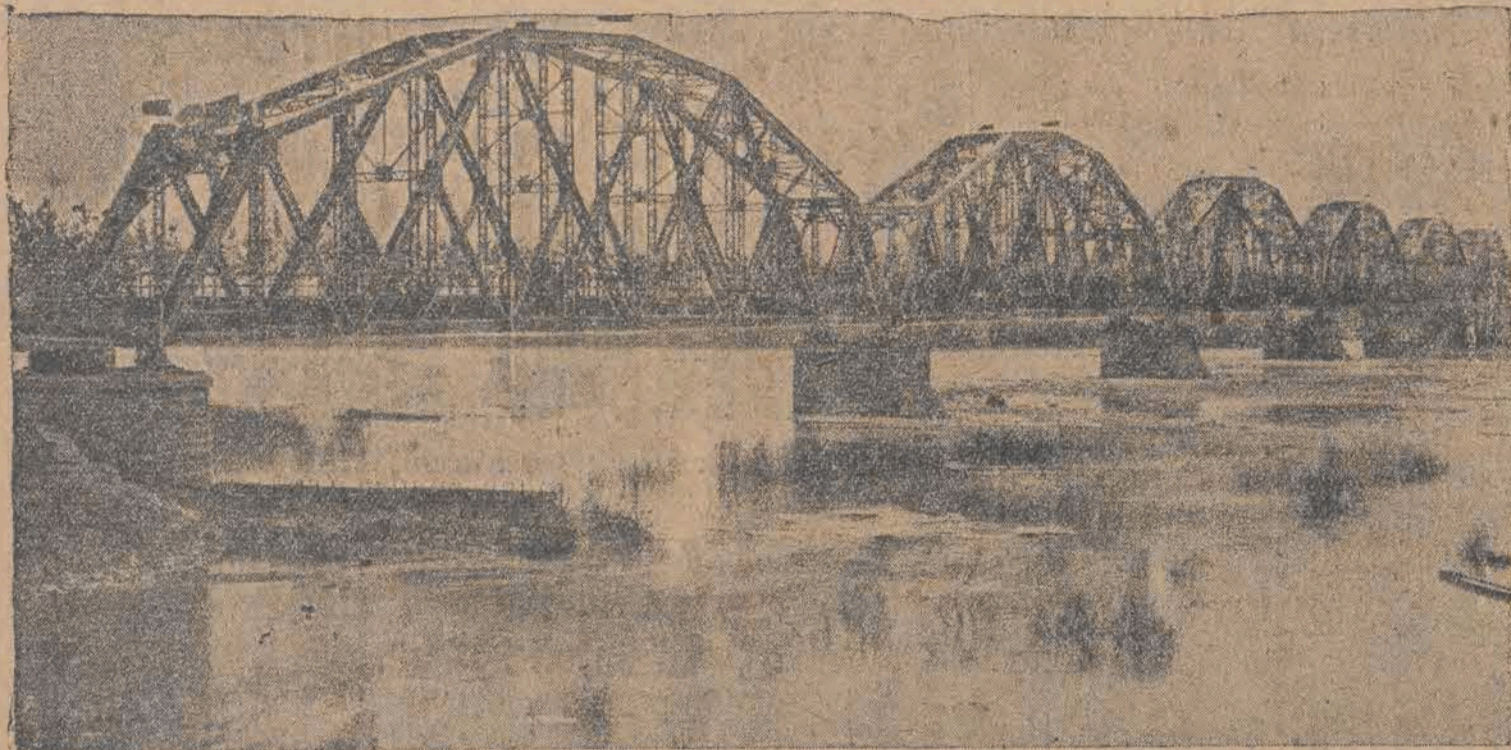
Ogólny widok nowego mostu; zdjęcie dokonane z mostu dotychczasowego prowizorycznego w czasie biegu pociągu.
