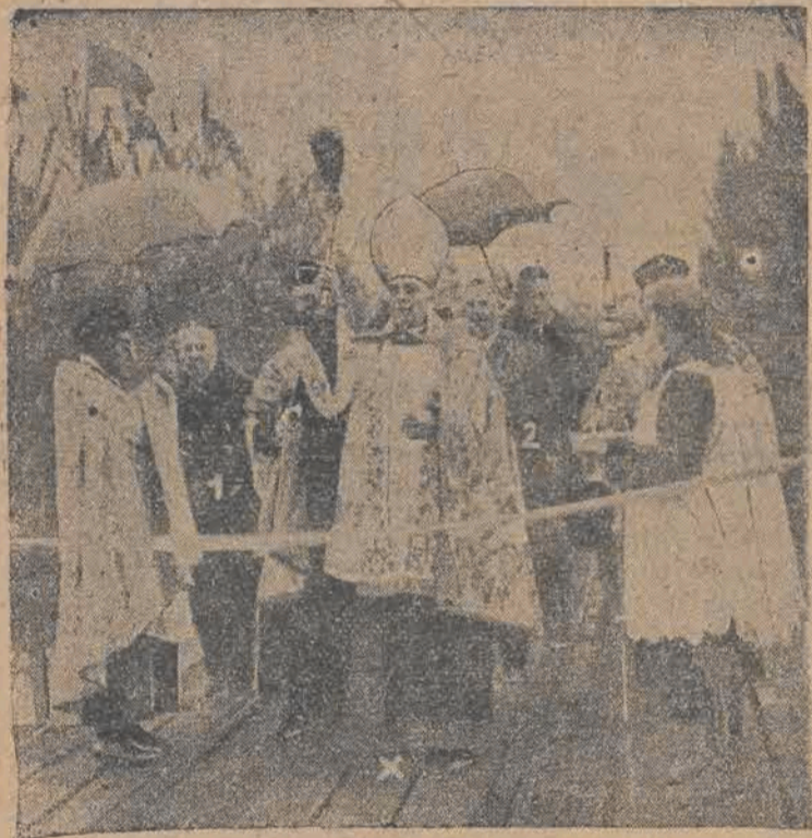
Poświęcenie mostu przez biskupa-sufregeję sandomierską ks. Ryksa (X) w obecności dyr. departamentu budowy i utrzymania min. kom. inż. Ciechanowickiego (1) i inż. Romockiego. (2)
