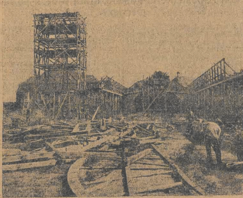
Prace nad poszczególnymi pawilonami Powszechnej Wystawy Krajowej są w pełnym toku. Na całym terenie PWK. pracuje armia robotników. Jest rzeczą pewną, że w dniu otwarcia wystawy wszystkie pawilony będą gotowe. Zdjęcie nasze przedstawia fragment budowy pawilonu spożywców na PWK.
