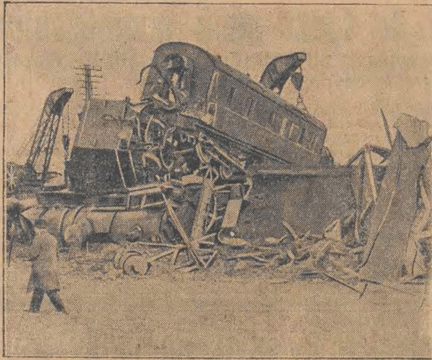
W Szkocji, w pobliżu stacji Wamphroy, zderzył się pędzący z szybkością 90 km. na godzinę ekspres z pociągiem towarowym. Obaj maszyniści oraz palacze na obu lokomotywach ponieśli śmierć na miejscu.
