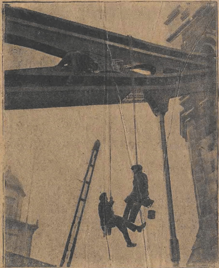
Naprawa słynnej Wieży (Tower) londyńskiej nie należy do robót najłatwiejszych. Robotnicy zawieszani są godzinami pomiędzy niebem a ziemią, pracując w najdziwniejszych i najzawrotniejszych pozycjach. Naturalnie, człowiek nie przyzwyczajony do znacznych wysokości dostałby od razu zawrotu głowy i strach, gdyby panowanie nad sobą, ogarnięty panickim lękiem wysokości. Doświadczeni pracownicy jednak nic sobie nie robią z przepaści, ścielącej się nisko, i nisko, że oko ledwie dostrzeże małe przedmioty, a ludzie, chodzący po ziemi, w dają się maleńkimi zabawkami. Oto na zdjęciu naszym widzimy małą podwędkę pomiędzy dwoma etapami pracy.
