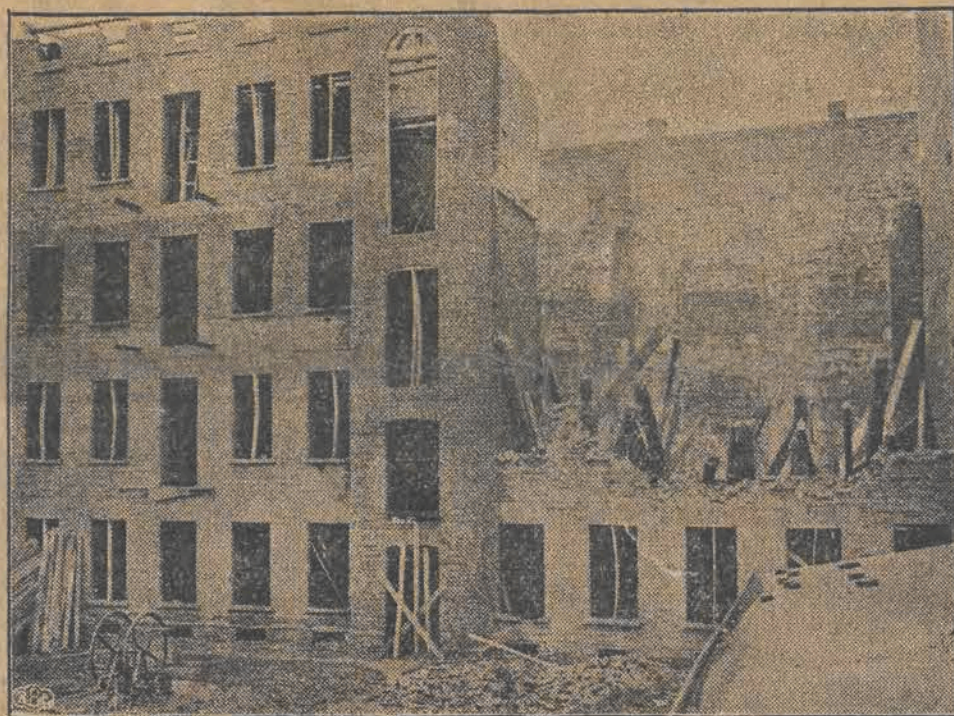
Jak doniósł wczorajszy „Express”, wczoraj zawalił się budujący się 3-piętrowy dom przy zbiegu ulic 28 pułku Strz. Kan. i Alei 1 Maja. Na zdjęciu dom po katastrofie.
