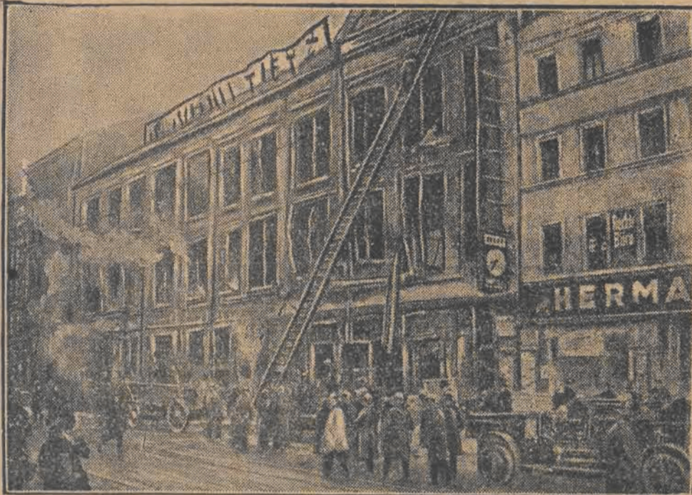
Przez 15 godzin zrędu zalewali strażacy strumieniami wody płonący olbrzymi gmach.
